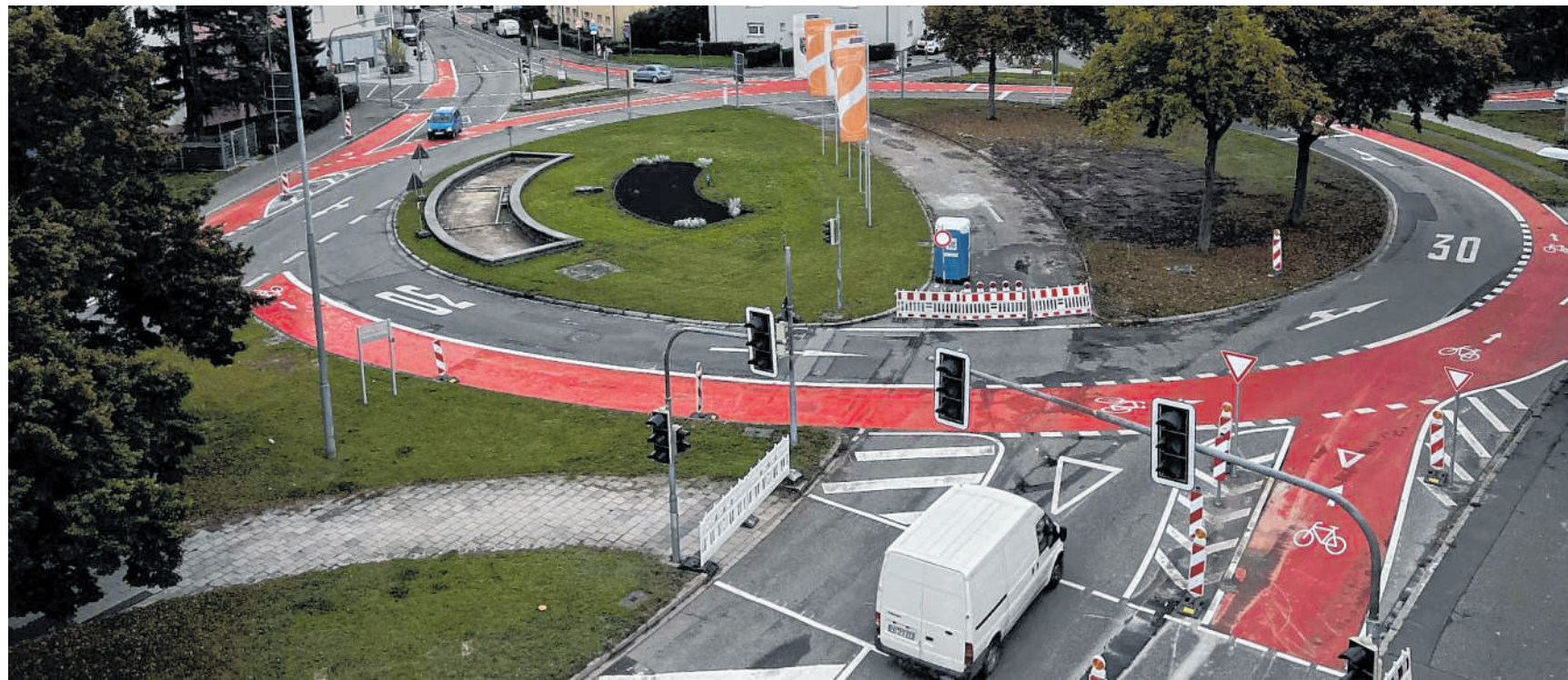
Das Rondell in Schwetzingen: Diese ampelarme Lösung wurde beim Deutschen Fahrradpreis als innovatives Infrastrukturprojekt bezeichnet.
