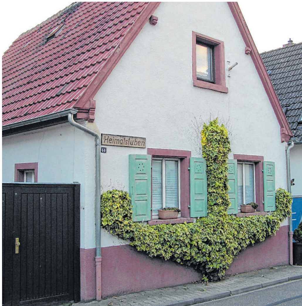
Kirchenstraße 2: Ein Weiterbetrieb des HBV ist ohne Beheizung des Gebäudes nicht möglich. Die Gemeinde bietet zudem keine Ausweichmöglichkeit.
