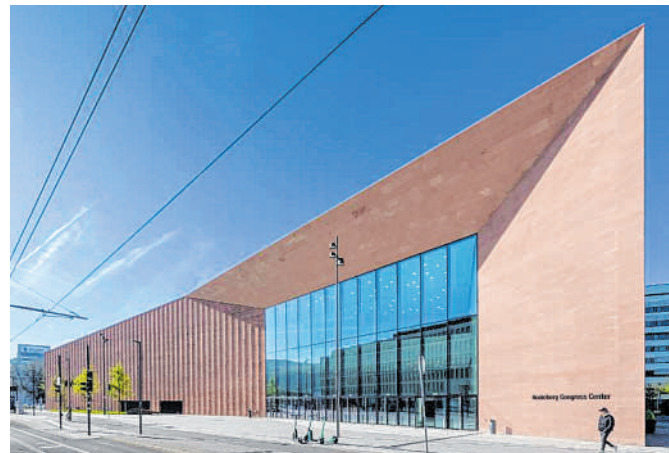
Das Heidelberg Congress Center: Die wellenförmig gestaltete Außenfassade aus regionalem Sandstein erinnert an einen Bühnenvorhang. BILD: HEIDELBERG MARKETING
