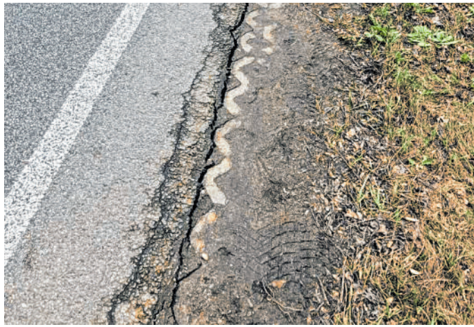
Im Bereich von Wiesloch/Frauenweiler: Auf einer Länge von rund 30 Meter werden Unebenheiten ausgebessert.
