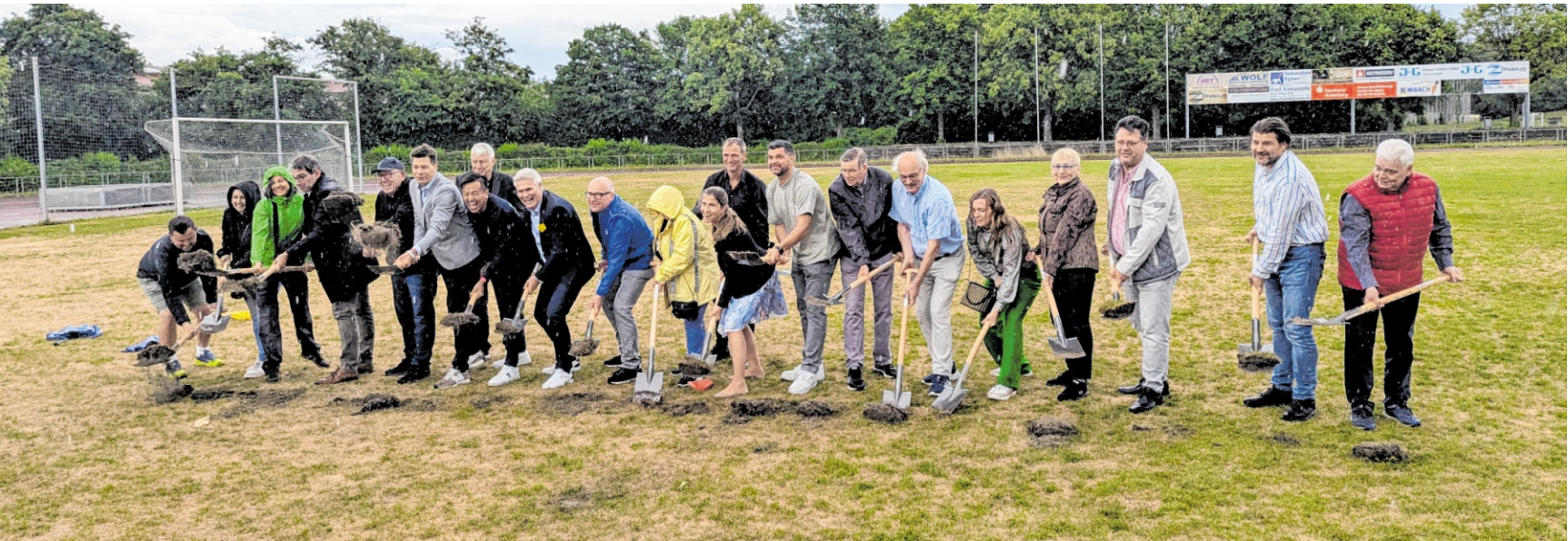
Gemeinsamer Spatenstich für die Sanierung des städtischen Stadions an der Ketscher Landstraße.
