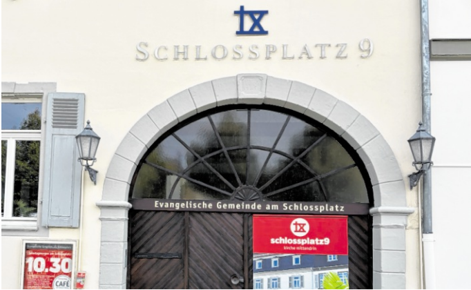
Das Gebäude der Evangelischen Gemeinde am südlichen Schlossplatz in Schwetzingen. BILD: ANDREAS LIN
