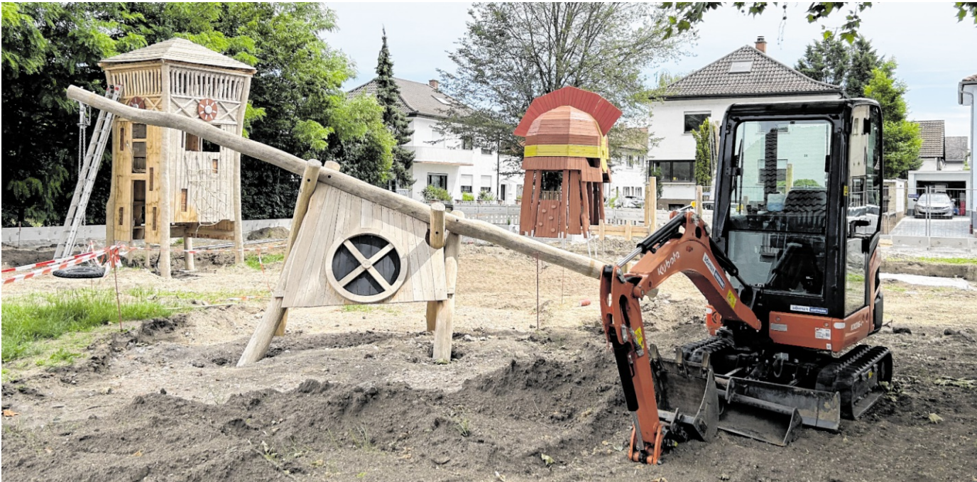
Wachturm, Katapult und Helm sind bereits installiert, der Rest des Römerspielplatzes in Rohrhof folgt nach und nach. Der Bagger bleibt allerdings nicht als Spielgerät.
