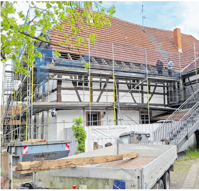
Die historische Fachwerkfassade des Dorfgemeinschaftshauses in Reilingen ist dreiseitig eingerüstet.
