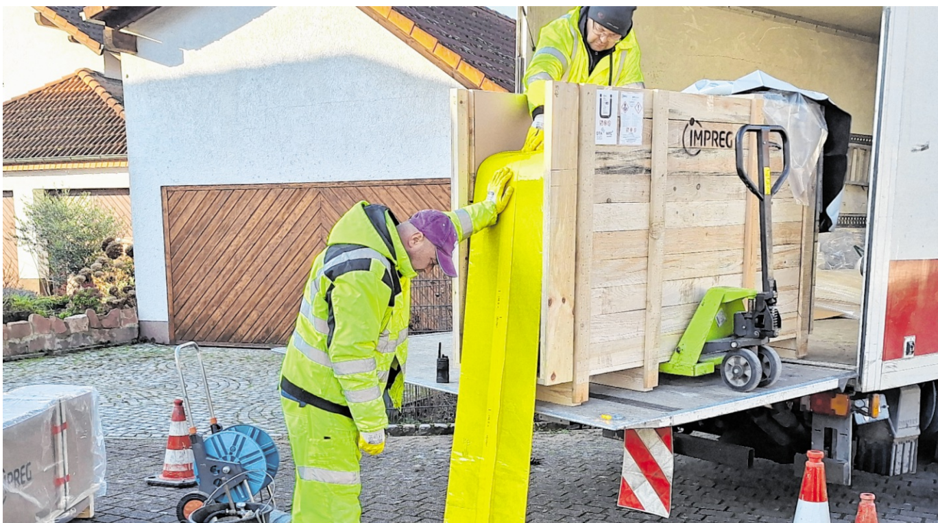
Der gelbe Schlauchliner wird in die alte Abflussleitung der Professor-Krämer-Straße eingezogen.
