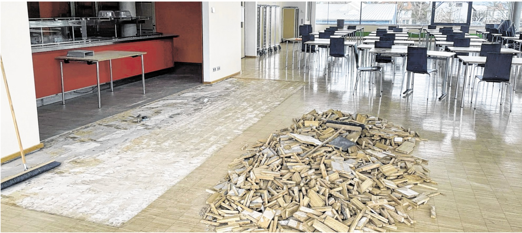
Noch sind die Bauarbeiten in der Hebel-Mensa nicht abgeschlossen. Bald kann der neue Caterer an der Theke links loslegen.
