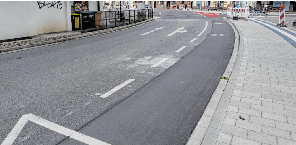
Die Stadt Heidelberg hat rund um den Hans-Thoma-Platz in Handschuhsheim die Fahrbahn neu markiert. Beispielsweise können in Fahrtrichtung Norden (Dossenheimer Landstraße) weiterhin zwei Autos nebeneinander fahren. Gleichzeitig haben Radfahrende nun einen eigenen Fahrstreifen, auf dem Autos nicht mehr fahren oder halten dürfen.
