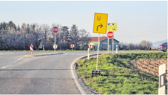
Da die L 598 zwischen Umspannwerk und Herrenwiesenweg voll gesperrt ist, ist eine Umleitung eingerichtet, wie hier an der Kreuzung Richtung Bruchhausen/Schwetzingen oder Leimen. BILD: GEMEINDE SANDHAUSEN
