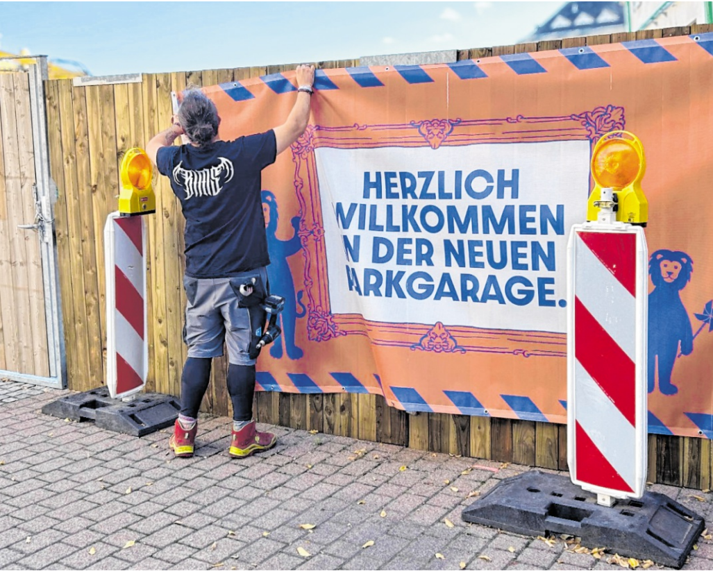
Der neue Holzzaun um das Baufeld des „Treffpunkt Leimen“ soll unter anderem vor Lärm und Staub schützen.
