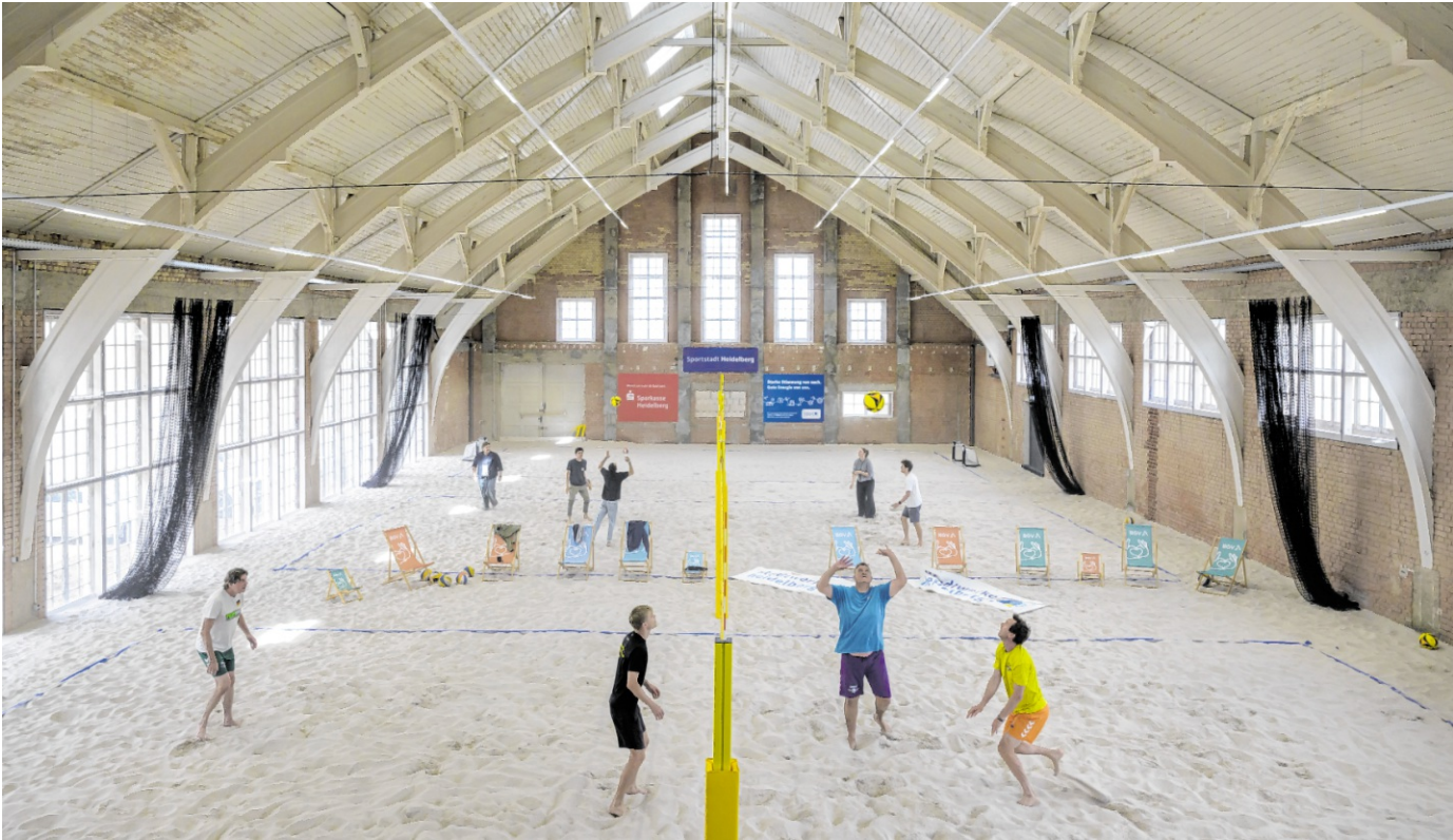
Das Hochbauamt der Stadt Heidelberg hat die 46 mal 21 Meter große Halle saniert, deren Dach an einen umgedrehten Schiffskörper erinnert. Neben drei Spielfeldern entstanden Umkleiden, Sanitärbereiche und Flächen für Vereins- und Techniknutzungen.
