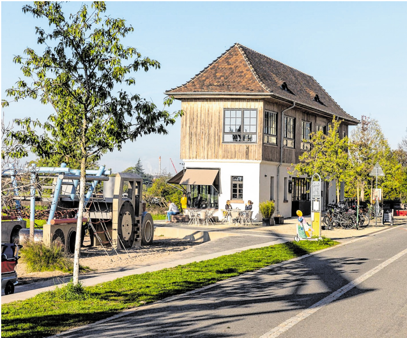
Das Stellwerk an der Bahnstadt-Promenade gilt als wichtiges technisches Kulturdenkmal der regionalen Verkehrsgeschichte. 1914 erbaut, erinnert es an die bewegte Vergangenheit der Bahnstadt, als auf dem Areal des früheren Güter- und Rangierbahnhofs noch mit Wasserdampf betriebene Lokomotiven fuhren.
