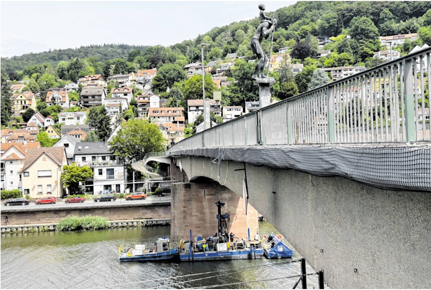
Derzeit wird der Pfeiler auf Ziegelhäuser Seite untersucht. Die Pfeiler sollen möglichst erhalten bleiben.
