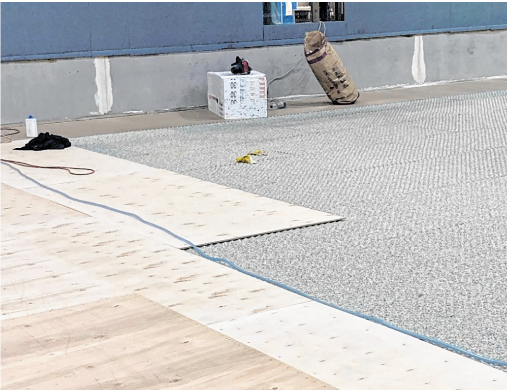
In der Kurpfalz-Schulsporthalle wird der knapp 30 Jahre alte Hallenboden erneuert.
