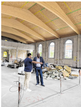
OB John Ehret informierte sich auf der Baustelle über den Stand der Arbeiten. BILD: STADT LEIMEN
