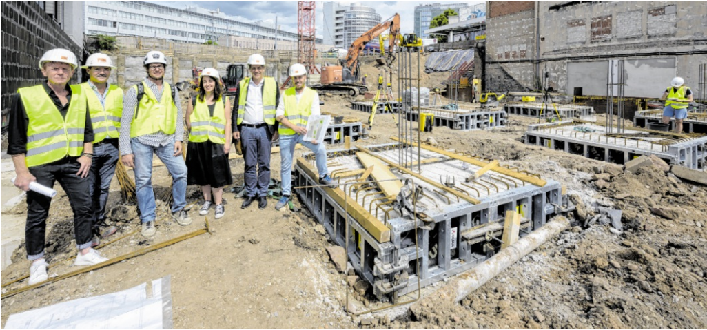
Erster Bürgermeister Jürgen Odszuck machte sich gemeinsam mit Kollegen des städtischen Hochbauamtes einen Eindruck über die Maßnahme. (v.l.: Leiter des städtischen Hochbauamtes Marc Tell Feltl, Bernhard Kolb (Bauleiter Firma Streib), Projektleiter Stefan Kornwinkel, Architektin des Hochbauamtes Elisabeth Kleinert, erster Bürgermeister Jürgen Odszuck und Architekt Thorsten Wagner von raumwerk) BILD: PHILIPP ROTHE
