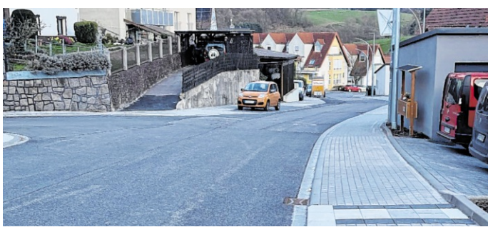
Endspurt in Oberflockenbach: Die Bauarbeiten werden früher als geplant abgeschlossen BILD: STADT WEINHEIM
