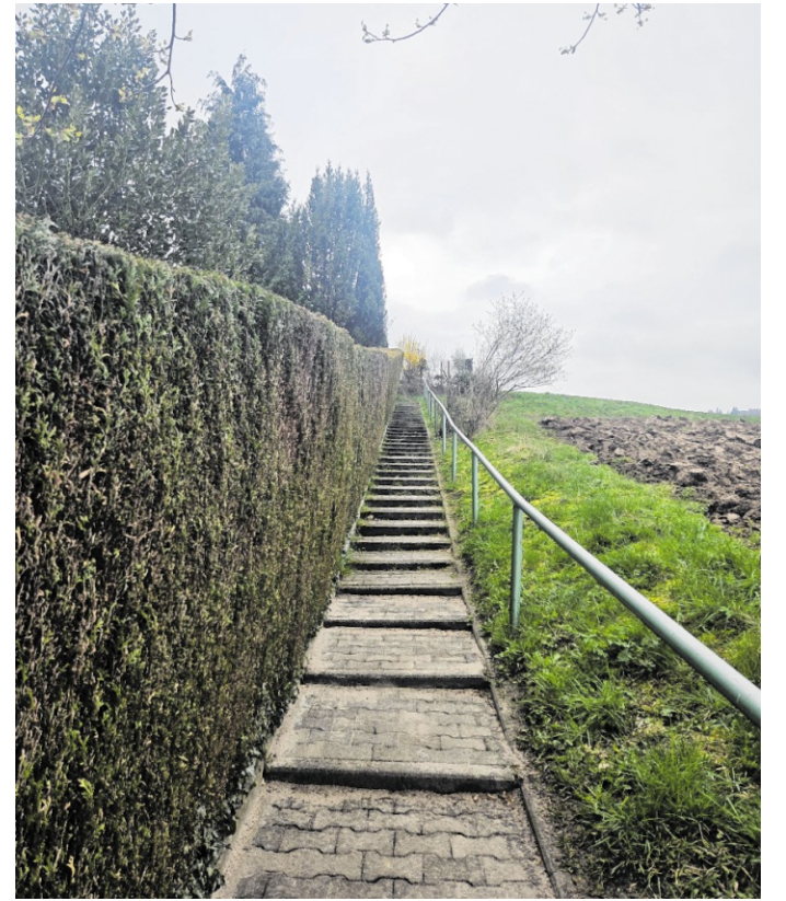
Auch die Treppe in Rippenweier wurde erneuert. Sie bietet nun mehr Sicherheit für Kinder und Fußgänger.
