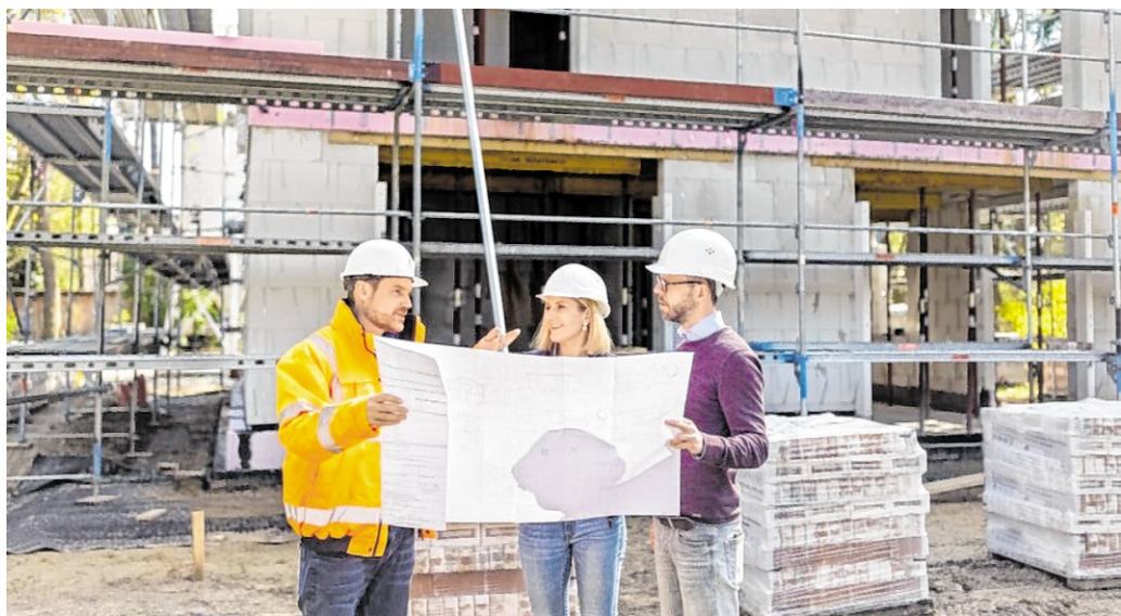
Unklare Baubeschreibungen und fehlende Abstimmung zählen zu den häufigsten Ursachen späterer Baumängel.
