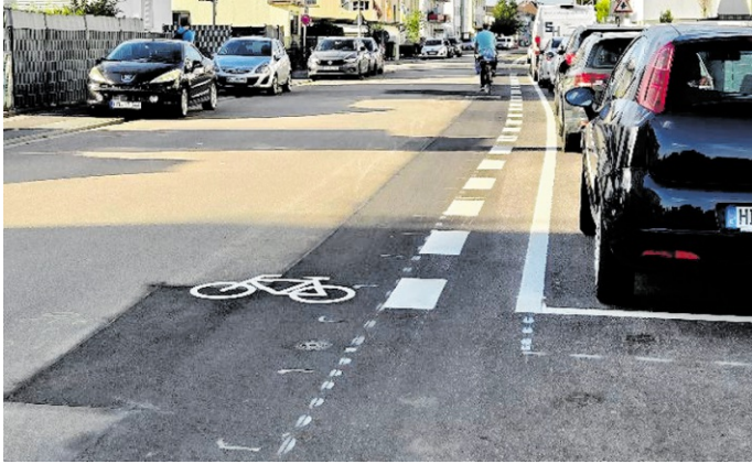
Die Fahrbahnmarkierung weist auf die Gefahr plötzlich geöffneter Autotüren hin. BILD: STADT WEINHEIM
