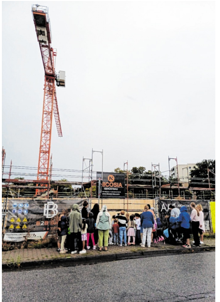
Kinder der Kita Kuhweid verfolgen auf der Baustelle die Fortschritte beim Neubau ihrer künftigen Einrichtung.
