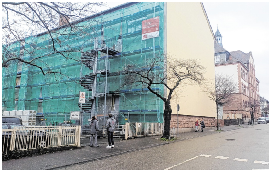
Nach der Modernisierung des Schulhofs geht es nun an die Turnhalle: Fassadensanierung, Vollwärmeschutz und neue Fenster sorgen für mehr Sicherheit und Energieeffizienz. BILD: STADT WEINHEIM
