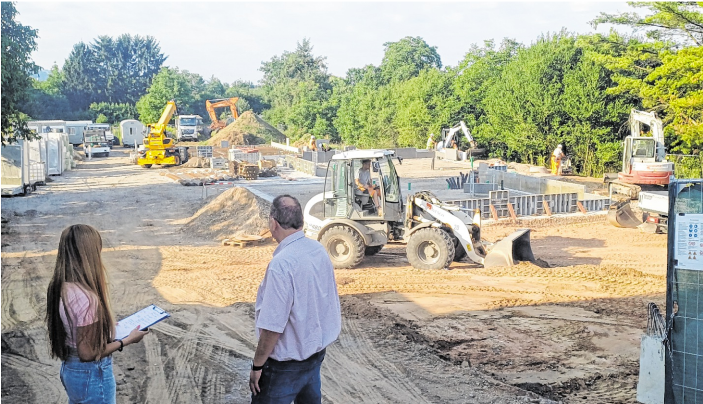
Auf der Baustelle der Flüchtlingsunterkunft am Dammweg in Sulzbach schreiten die Arbeiten planmäßig voran.
