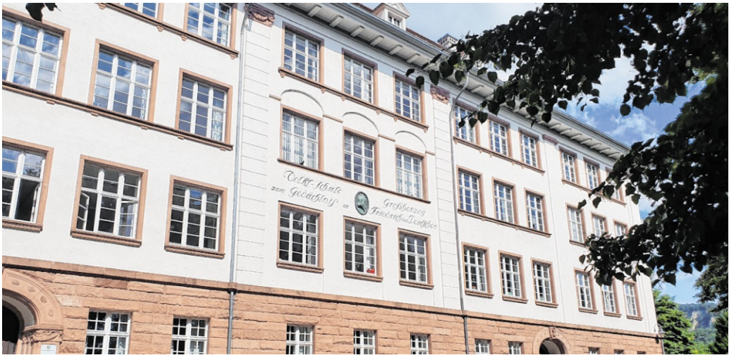
In der Friedrich-Grundschule wird die ehemalige Hausmeisterwohnung saniert, um die Räumlichkeiten für die Ganztagsbetreuung der Grundschulkinder nutzen zu können. BILDER (2): STADT WEINHEIM
