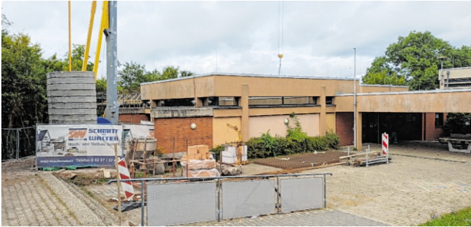
In Oberflockenbach entsteht in einem Anbau ein etwa 78 Quadratmeter großer Betreuungsraum und ein erweiterter Flurbereich für die Betreuung der Schulkinder nach dem Schulunterricht.
