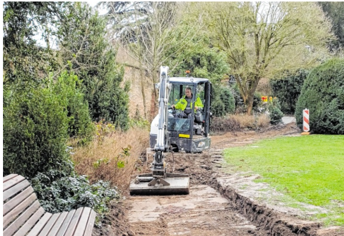
Neuer Unterbau, frischer Asphalt: Ein Hauptweg im Schlosspark erhält eine nachhaltige Sanierung – und ist schon bald wieder frei für Spaziergänger. BILD: STADT WEINHEIM
