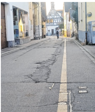
Zentrale Straße in Lützelsachsen wird saniert BILD: STADT WEINHEIM
