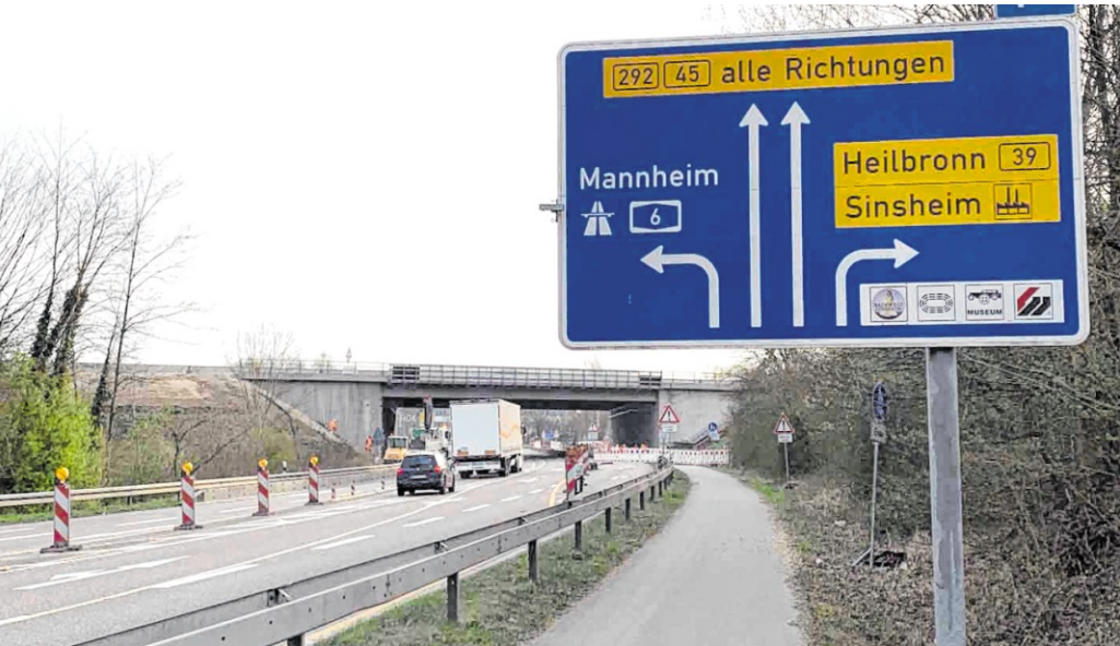
Im Rahmen des Erhaltungsprogramms der ViA6West wird zwischen der BAB 6 Anschlussstelle Wiesloch/Rauenberg (32) und der Anschlussstelle Sinsheim (33a) auf einer Länge von circa 1,2 Kilometern im Bereich Sinsheim-Dühren die Fahrbahn in beiden Fahrtrichtungen teilweise erneuert
