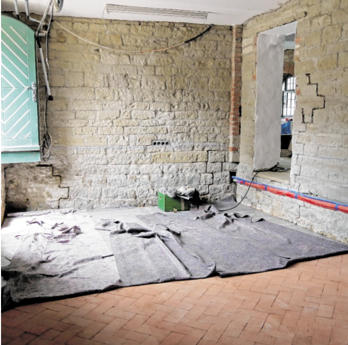
Aktueller Renovierungsstand im Rathauskeller Mühlbach.
