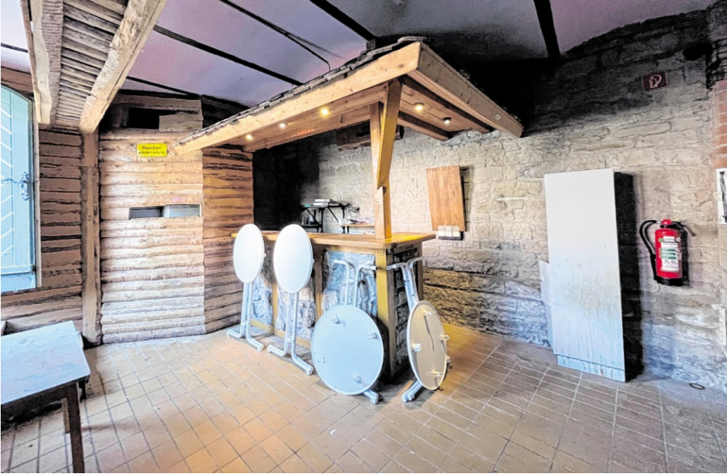
Rathauskeller Mühlbach vor der Renvoierung.
