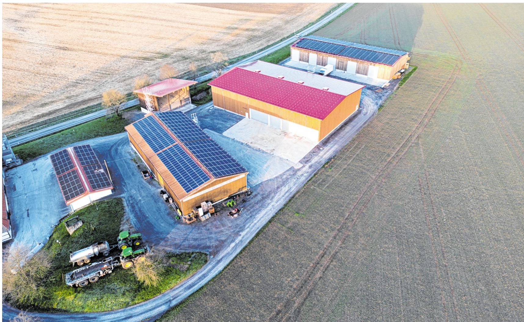
Blick auf die Dächer des Eulenhofes.
