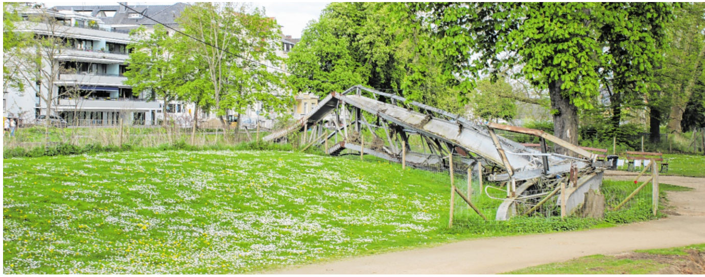
Die aus dem Jahr 1910 stammende Maria-Hilf-Brücke wurde von der Flut 2021 mitgerissen und im Kurpark von Bad Neuenahr „abgelegt“. Ein Mahnmal soll sie allerdings nicht werden, sondern bald entfernt werden.
