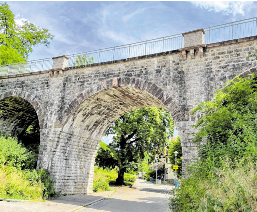
Imposantes Viadukt in Schatthausen aus dem Jahre 1900
