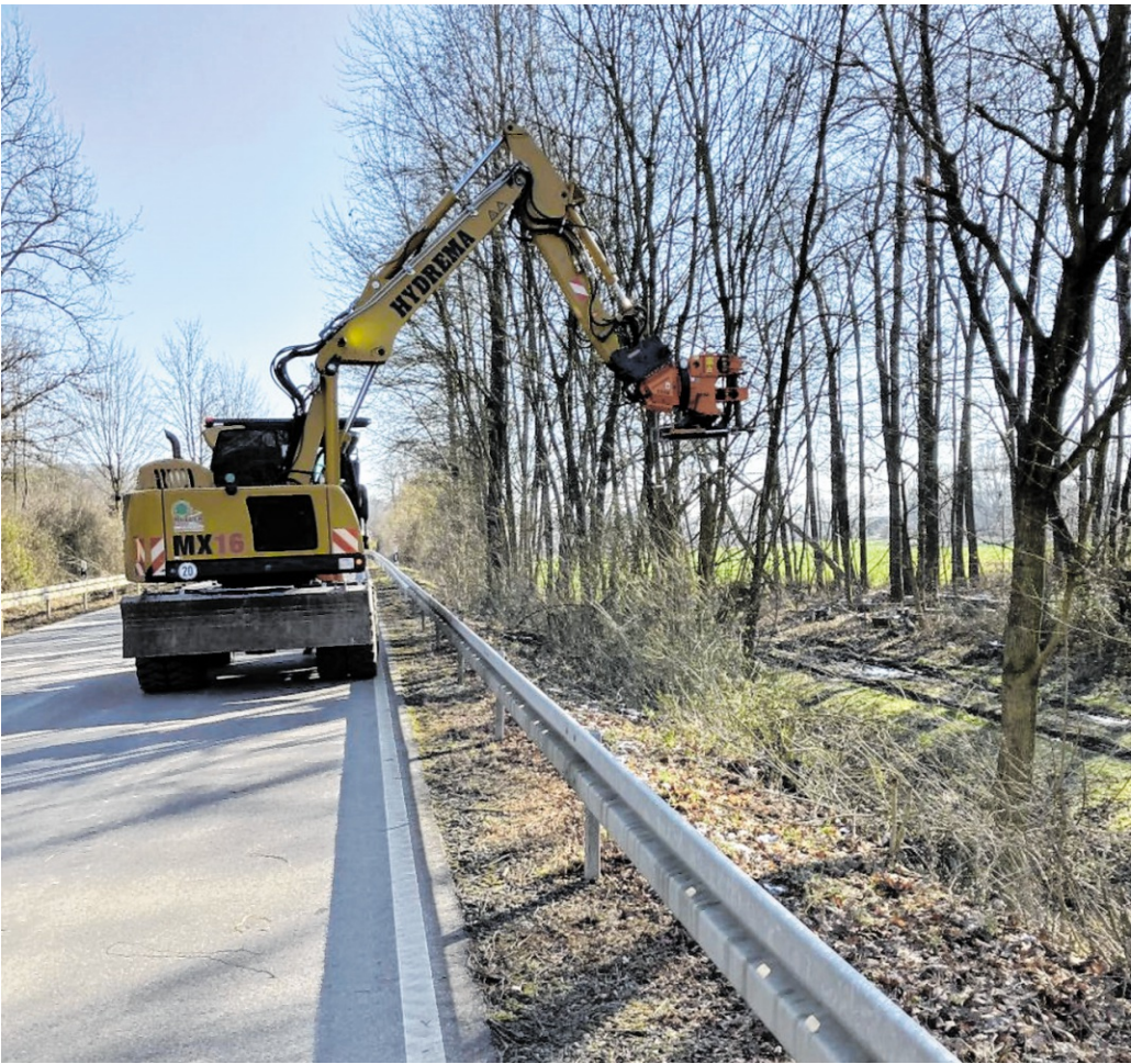
Mit Gehölzbagger und Motorsäge werden Hecken und Bäume entlang von Bundes-, Landes- und Kreisstraßen fachgerecht zurückgeschnitten. BILD: LANDRATSAMT RHEIN-NECKAR-KREIS
