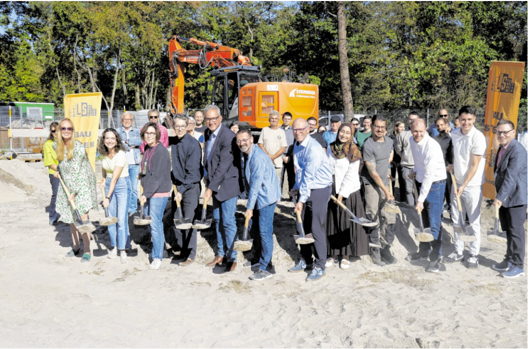
Mit dem ersten Spatenstich haben die Arbeiten für das neue Betriebsgebäude des Tierparks begonnen, das bis Frühjahr 2028 fertiggestellt werden soll.
