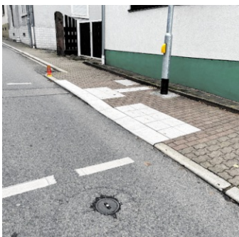
Neue Bordsteine und taktile Noppenplatten sorgen für mehr Barrierefreiheit. BILD: GEMEINDE NUBLOCH
