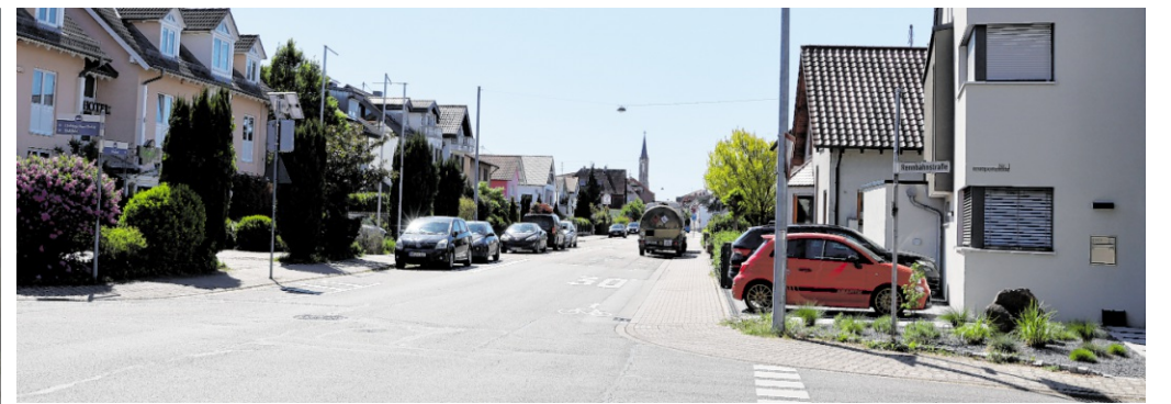
Die Schwetzinger Straße in Walldorf wird voraussichtlich ab November saniert. Die Arbeiten zwischen Hintere Graben-/Hildastraße und Rennbahn-/Bleichstraße sollen etwa 13 Monate dauern. BILD: STADT WALLDORF
