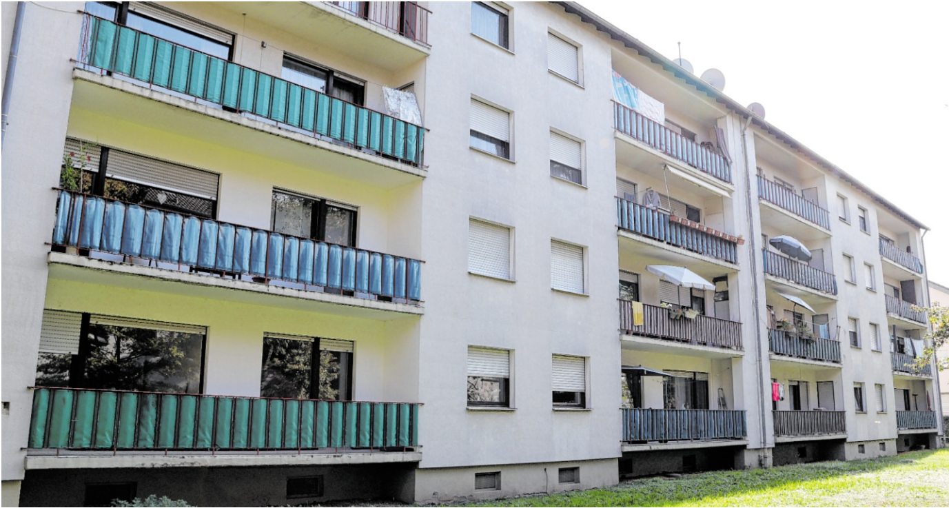
Die Wohngebäude in der Johann-Strauß-Straße 15 und 17 werden im kommenden Jahr energetisch saniert.
