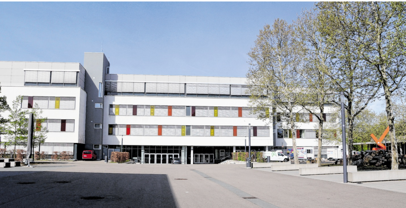
Auf dem Gelände des Schulzentrums entstehen beim Fest „Briefe aus der Zukunft“ und fantasievolle Walldorfer Wesen.
