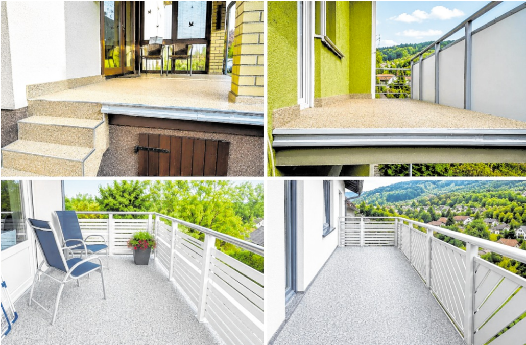
Das Dielheimer Unternehmen happySystem, spezialisiert sich seit 2010 auf die Sanierung von Balkonen, Terrassen und Dachterrassen. BILD: HAPPYSYSTEM
