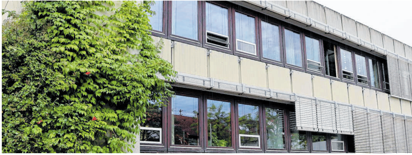
Unter anderem zur Erhaltung der Artenvielfalt und für ein besseres Klima: Neben einer Dachbegrünung wird nun auch die Fassadenbegrünung gefördert. BILD: STADT WALLDORF
