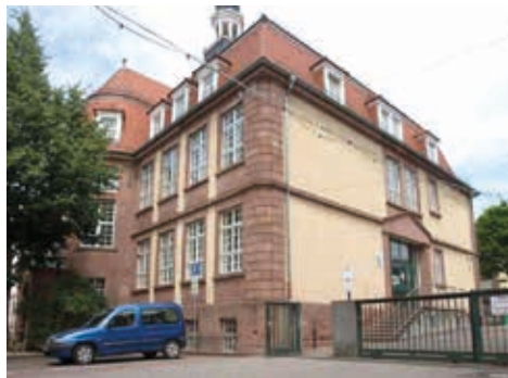
Turmschule in Leimen.
