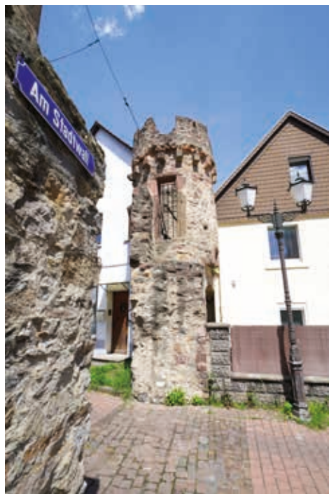
Mauerreste des Leimener Franzosenturms. Bild: Stadt Leimen
